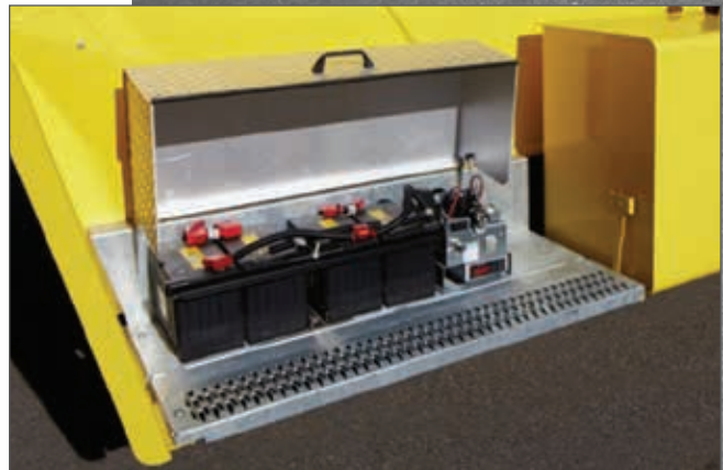
Mantenimiento de la batería
