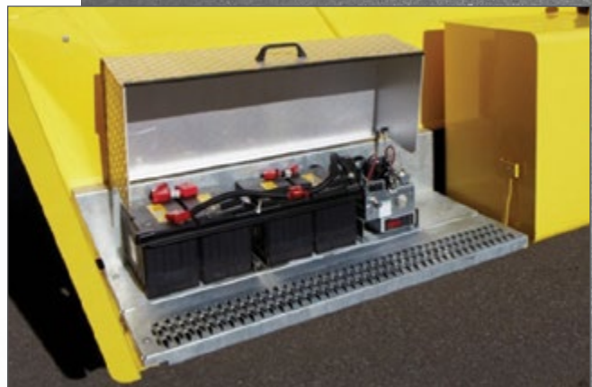
Mantenimiento de la batería
